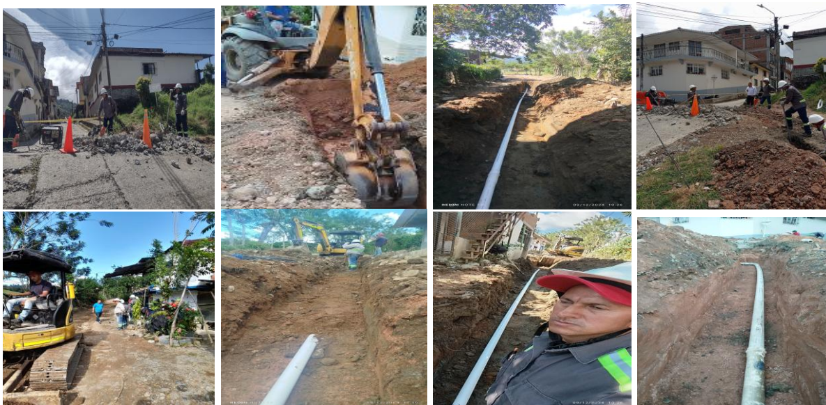
Ampliación y reposición de acueductos 2024.
