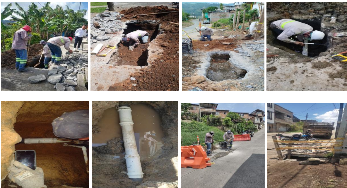
Atención de daños en redes de acueducto 2024
