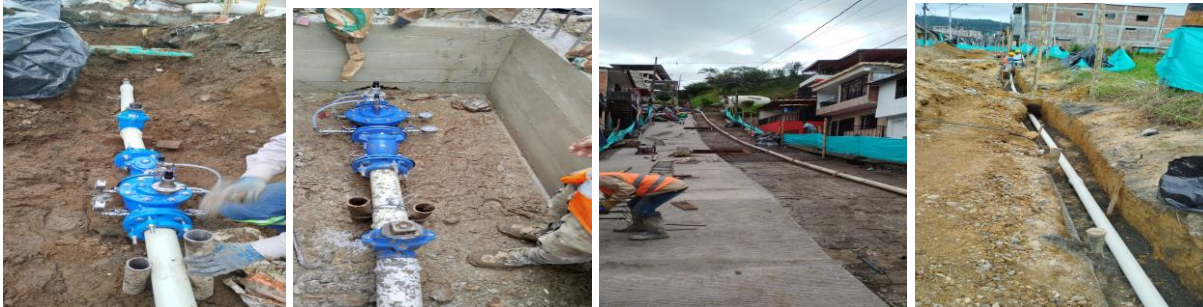
Cambio redes de acueducto, redes alcantarillado e instalación de válvulas de sectorización y válvula reguladora
