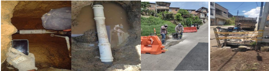
Atención de daños en redes de acueducto
