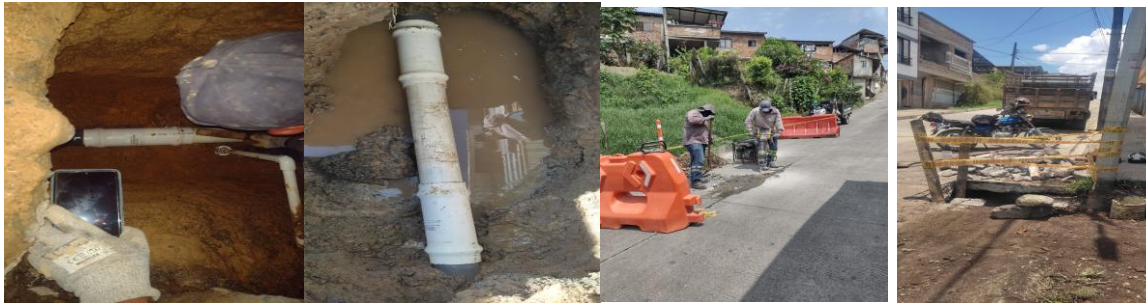
Atención de daños en redes de acueducto
